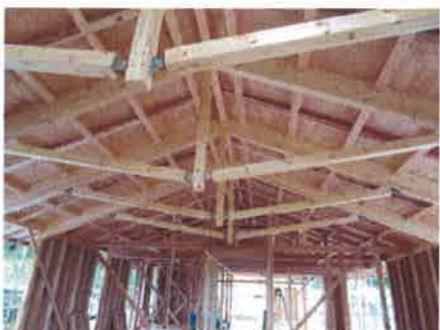
上棟後の内部の様子
